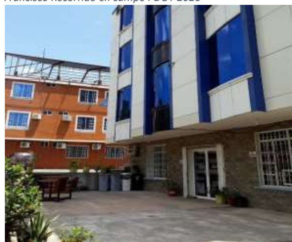
Fotografía 2- 16 Infraestructura hotelera / Comunidad San Francisco Recorrido en campo PDOT 2020
