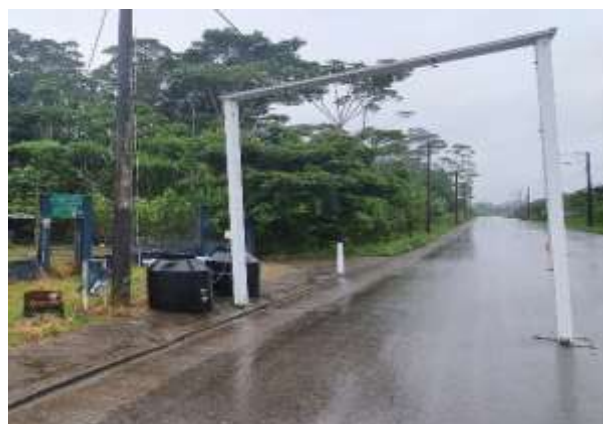
Fotografía 2- 59 : Vía asfaltada –eje principal/ Recorrido en campo 2020
