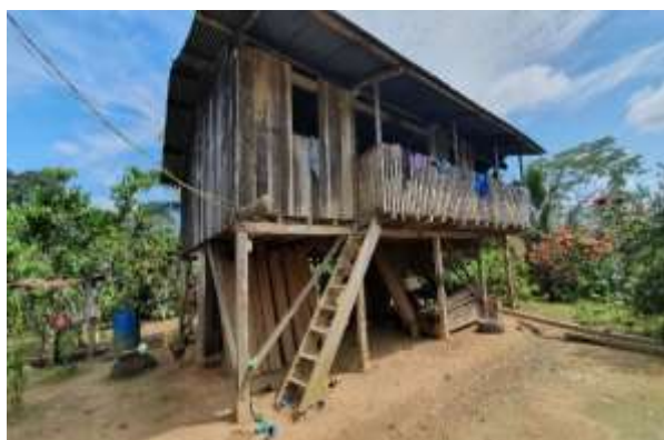
Fotografía 2- 58 Viviendas típica / Comunidad Nuevos Horizontes / Recorrido en campo2020
