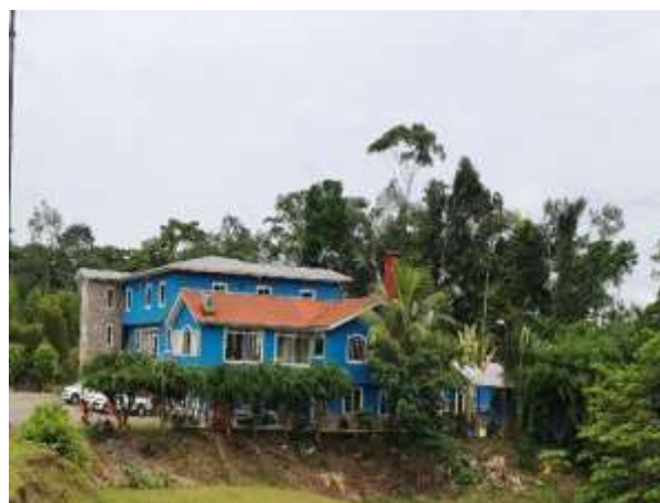
Fotografía 2- 15 Infraestructura hotelera / Comunidad San Francisco Recorrido en campo PDOT 2020
