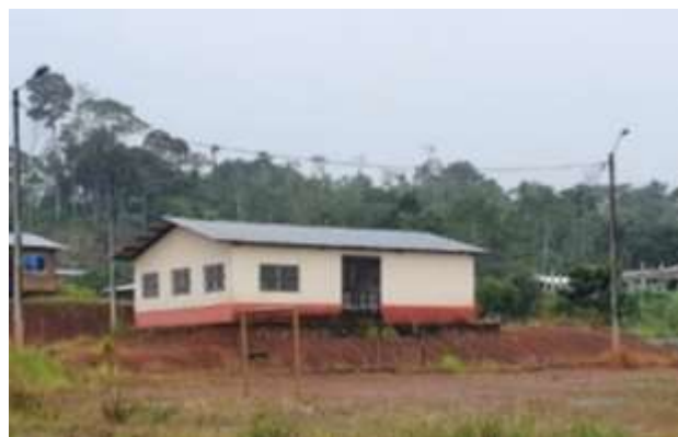
Fotografía 2- 46 Casa comunal/ Comunidad Ciudad Blanca Recorrido en campo PDOT 2020
