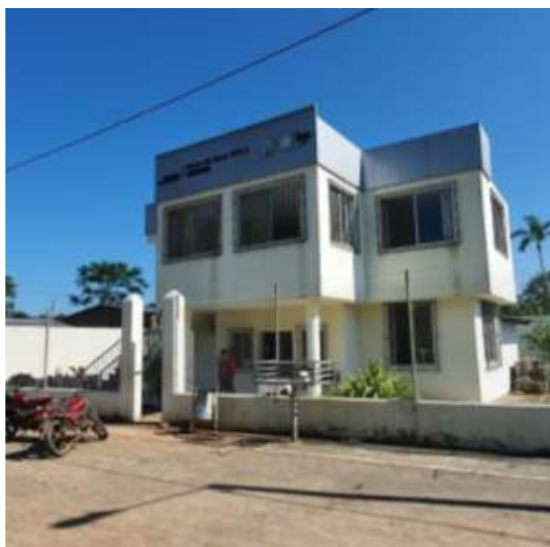
Fotografía 2- 32 : Centro de Salud La Western Colono/Comunidad La Western Fuente: Recorrido en campo PDOT 2020
